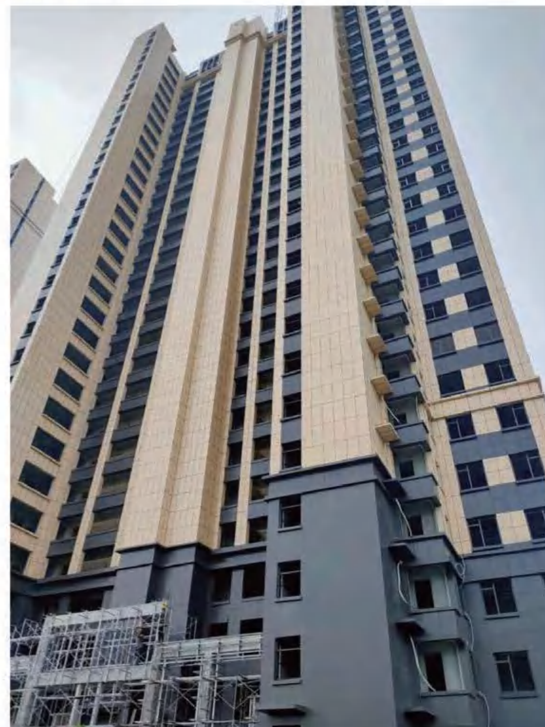
工程实例 Project examples
