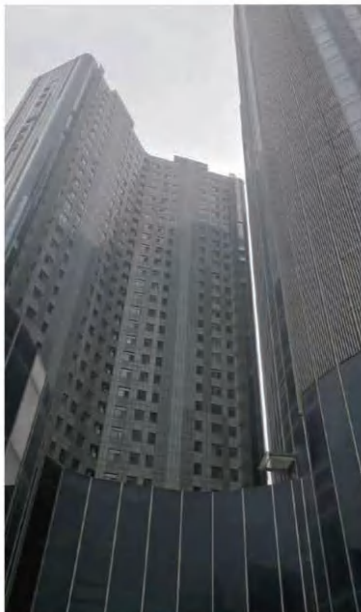
淄博北成金住楼 氟碳漆一体板
