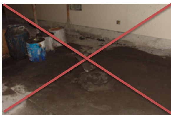
图11 严禁直接人工在地上搅拌
