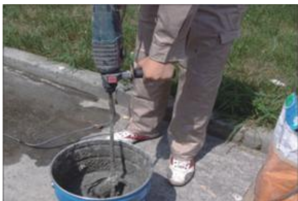
图10 应电动搅拌器搅拌
