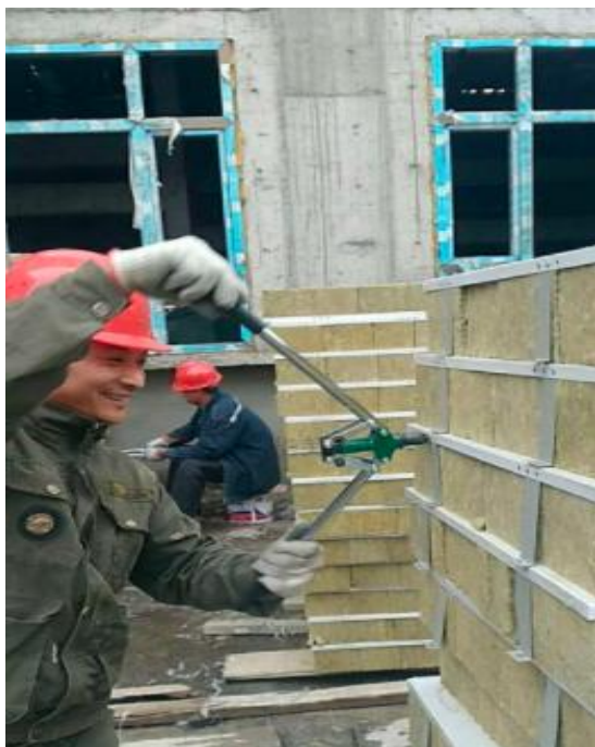
图 20 预制角码工艺示意图
