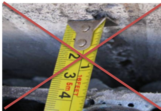
图 18 严禁砂浆厚度超出 30mm
