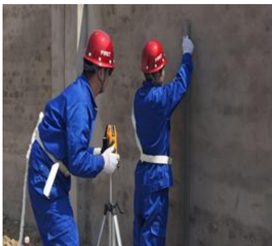
图 4 检查基层抹灰平整度
