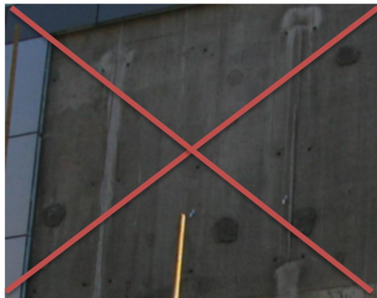
图 27 严禁锚固件使用数量未达设计要求
