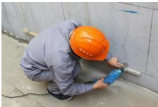
图 19 首层承托件安装示意图
