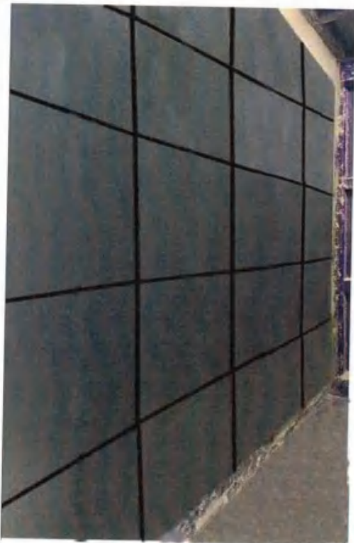
试验墙体全貌：表面完好无破坏
